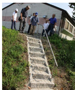
手すりも設置しました
